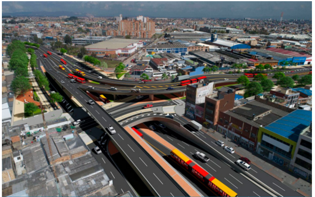
Comerciantes y residentes de Venecia se ven afectados por las obras del Proyecto Avenida 68
