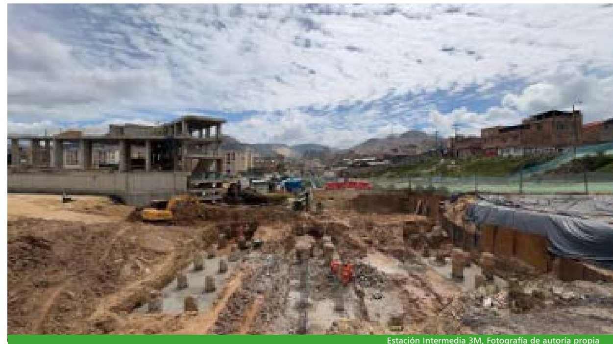
Estación Intermedia 3M, Fotografía de autoría propia
