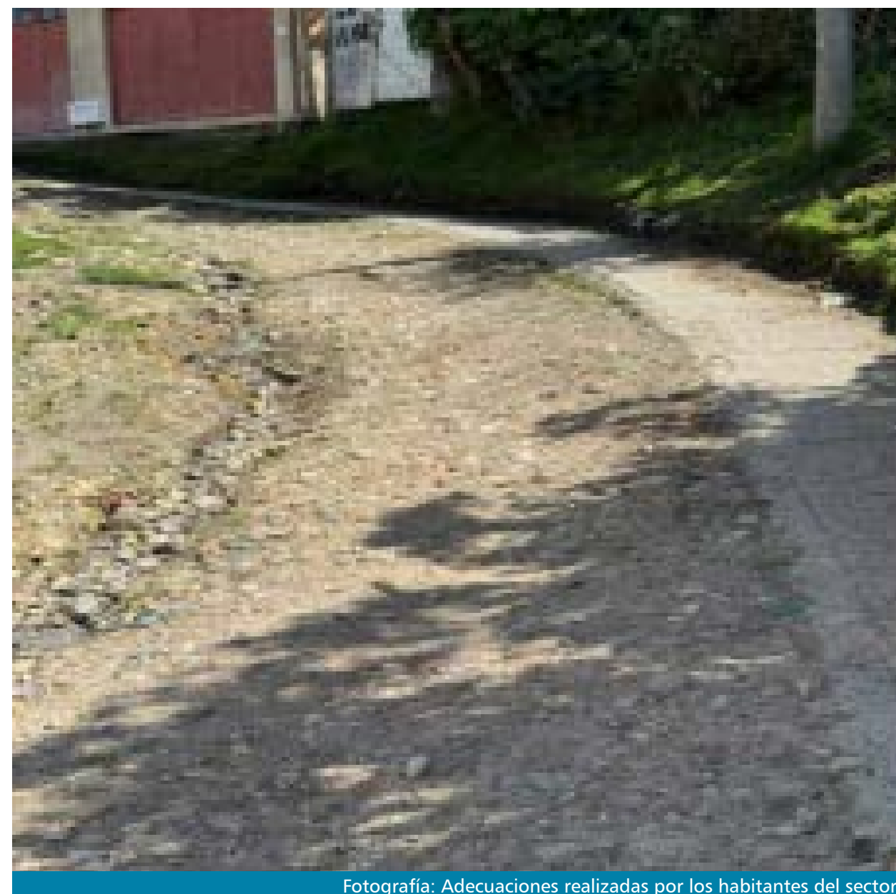
Fotografía: Adecuaciones realizadas por los habitantes del sector.
