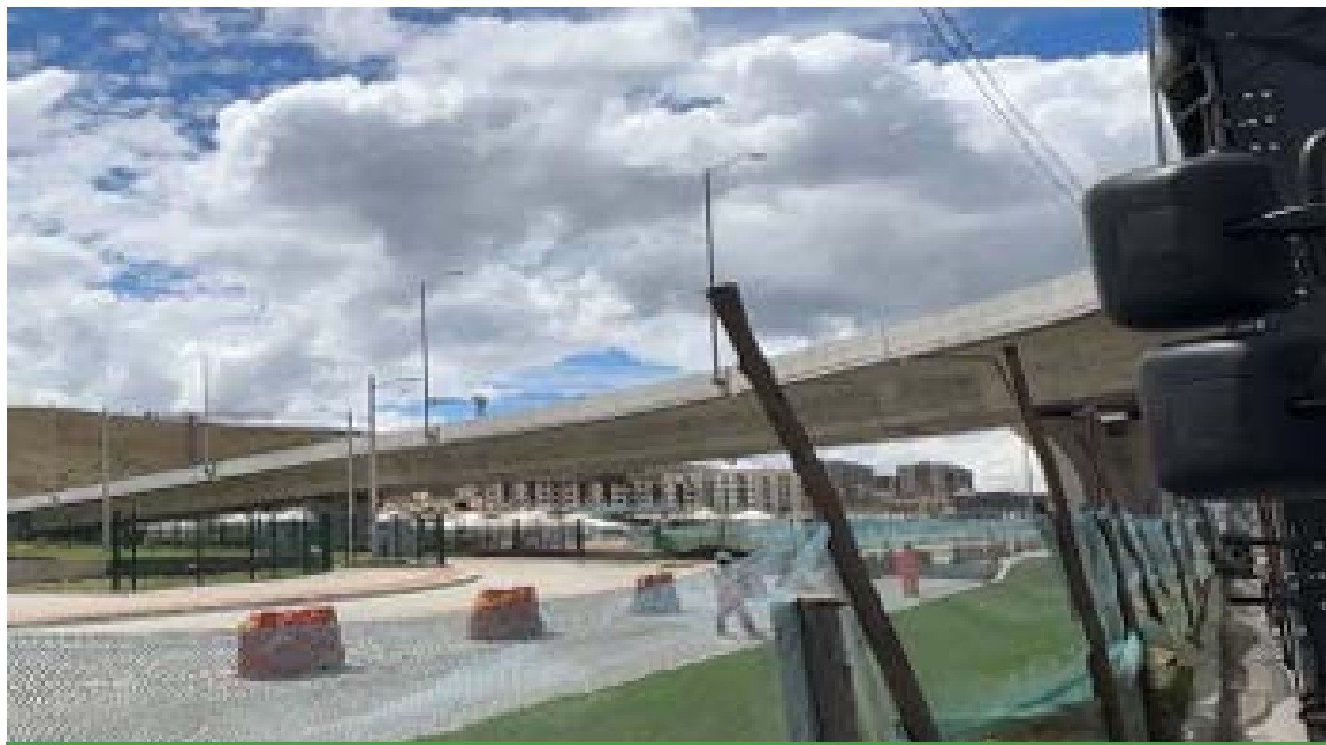
Puente vehicular El Vínculo, Fotografía de autoría propia
