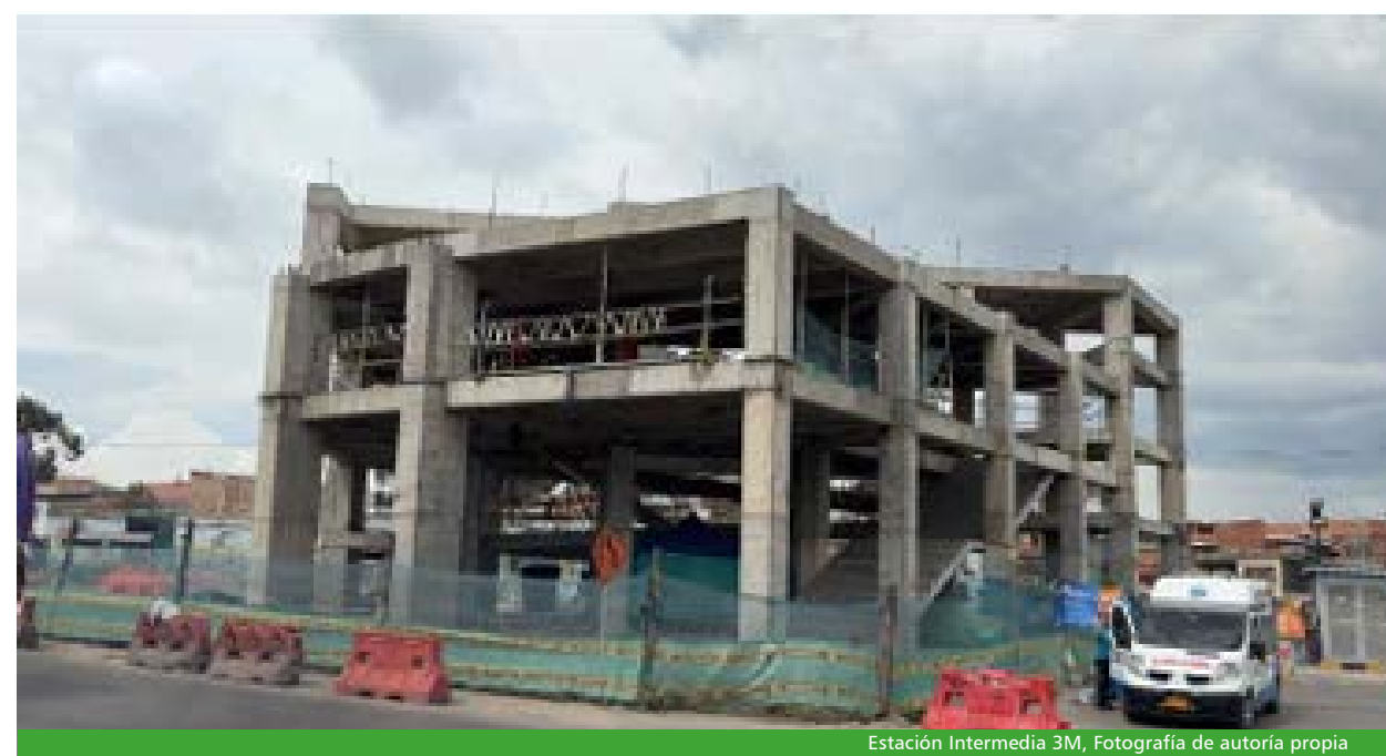
Estación Intermedia 3M, Fotografía de autoría propia
